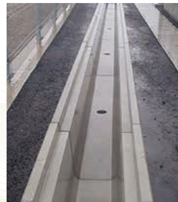
●雨天時の様子(水抜き穴加工)
