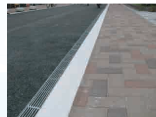
東京：港区芝5丁目道路整備工事
