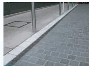
東京都銀座某百貨店外構工事
